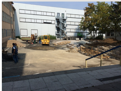
Neuer Asphalt Goethe-Schulhaus
